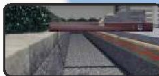
۶- برش کف کانال (محل خروجی کف کانال)
